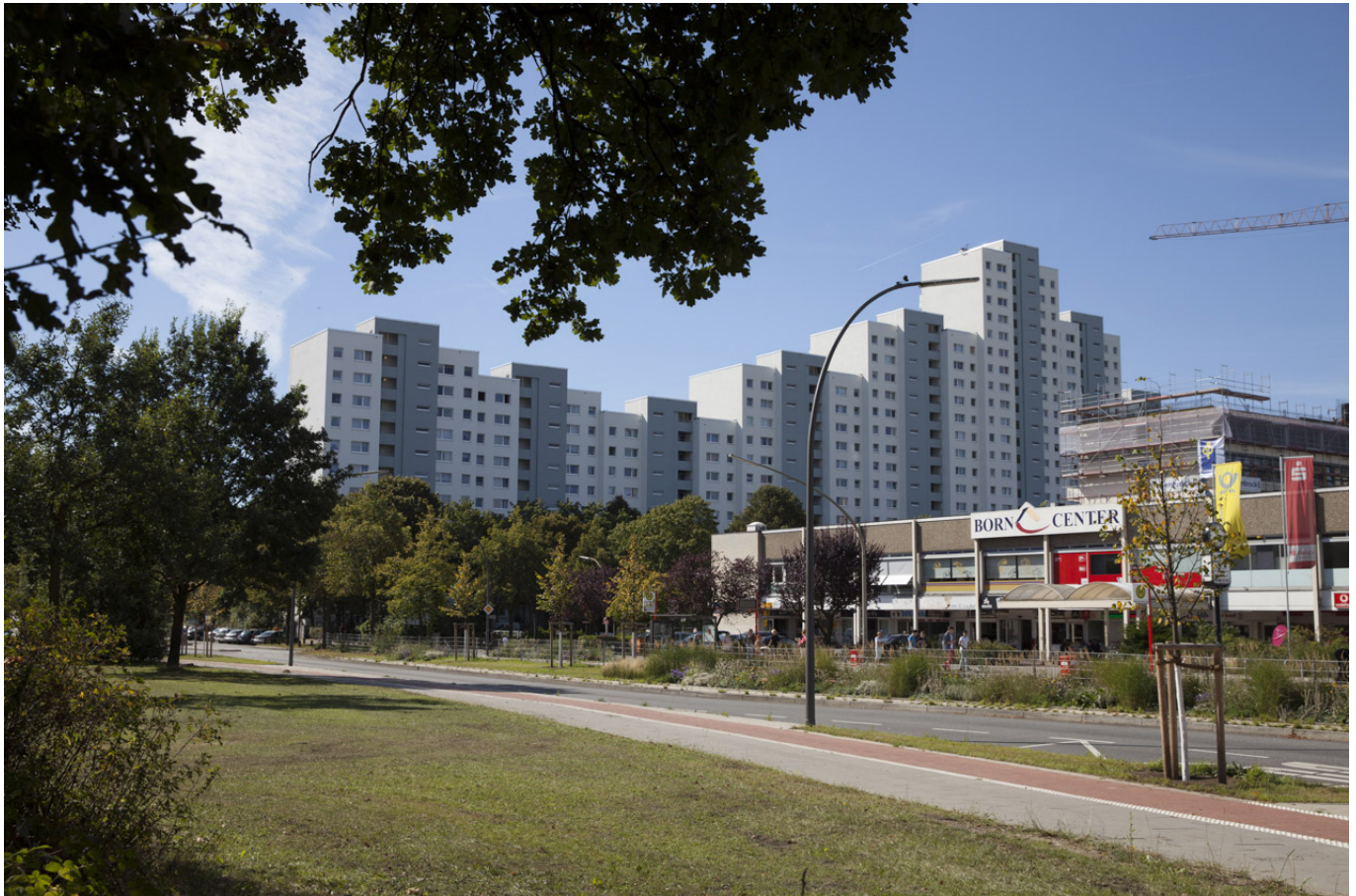
„Moderner Wohnungsbau“ am Osdorfer Born (Foto: ProQuartier)
