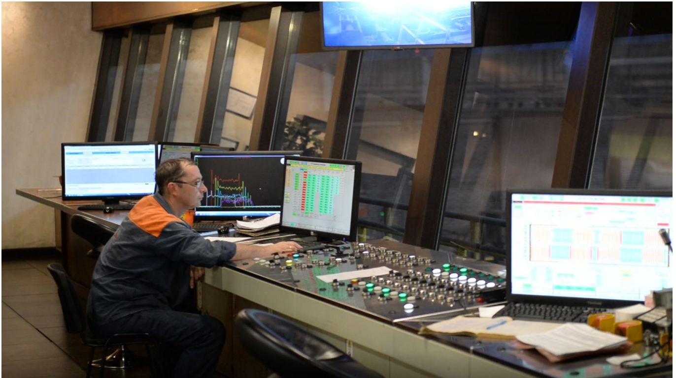
Leitzentrale des Röhrenwalzwerkes
