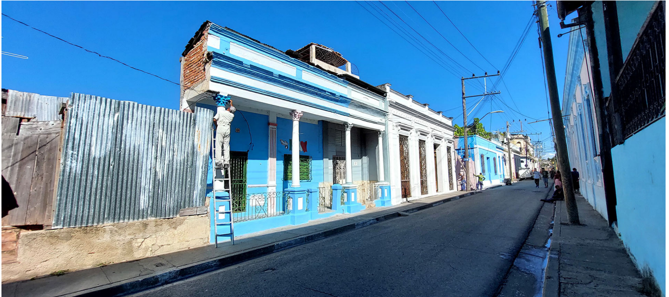
Foto: Malerarbeiten in Havanna
