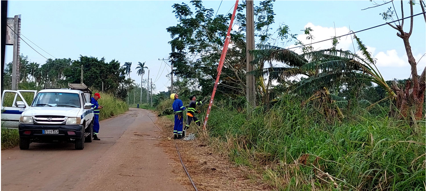
Foto: Reparaturarbeiten im Vorort von Havanna - Quelle: Eric Fischer
